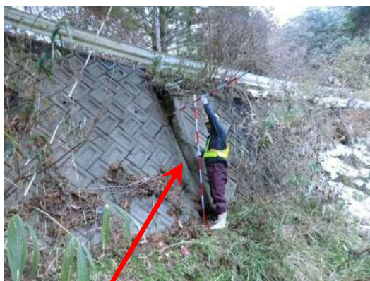
擁壁の前傾？押し出し？
